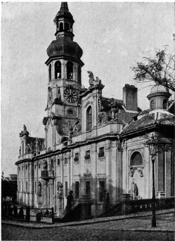
Průčelí chrámu v Lorettě
